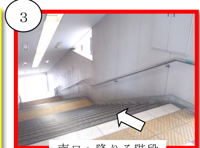
南口へ降りる階段 (北側の階段)
