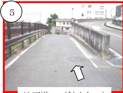
地下道へ (斜め左へ)
